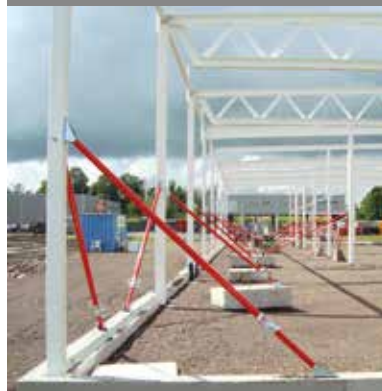
Skråstøtter til søylemontering
