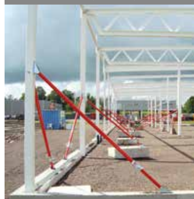
Skråstøtter til søylemontering
